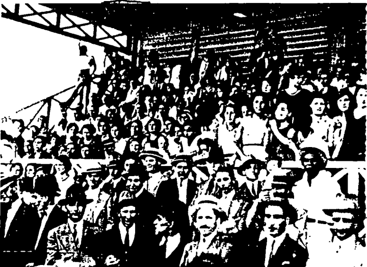
Hipódromo da Mooca - Arquibancada ano de 1931
